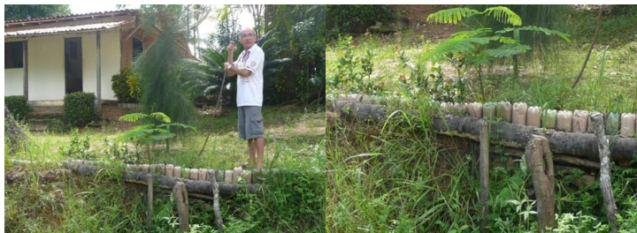
Figura 02 – Pequena contenção de terra com garrafas PET e troncos de árvores, na casa do Prof. José Luiz Teixeira Gomes, Vila Mota (PA).
